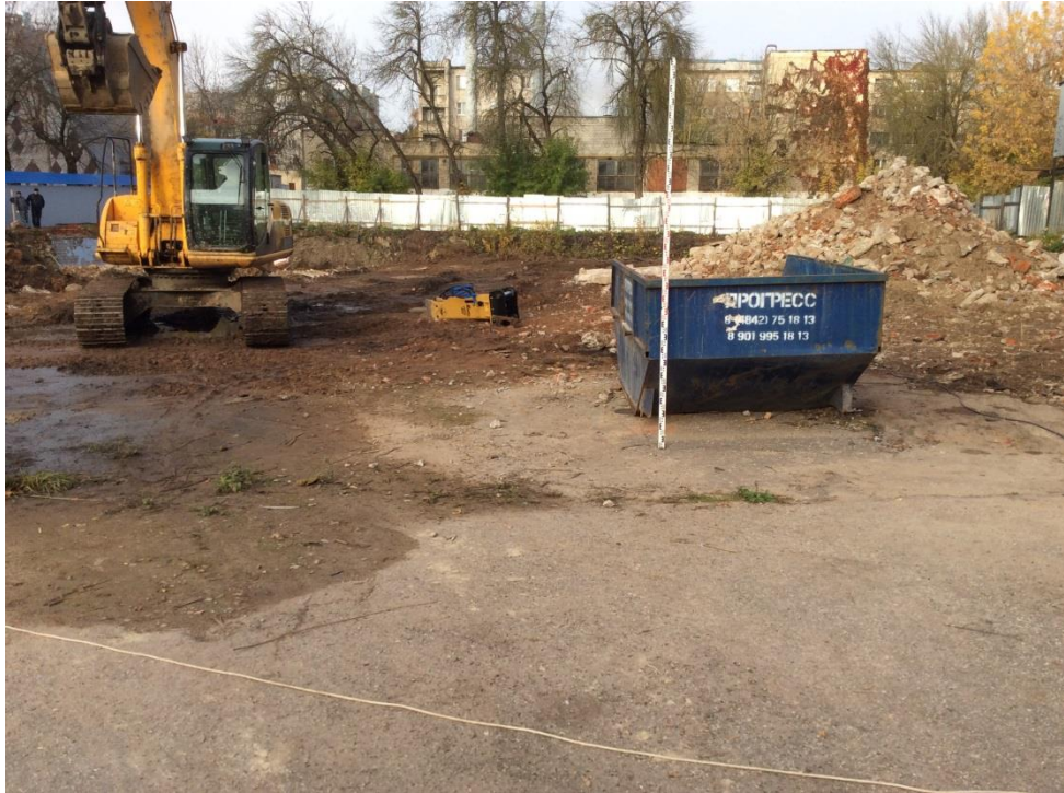
Рис. 12. Место проведения археологических разведок на земельном участке с кадастровым номером 40:26:000264:841 под объект «Многоквартирный жилой дом со встроенно-пристроенной автостоянкой по адресу: г. Калуга, ул. Пролетарская, д. 129». Видовая точка 2. Вид с востока.
