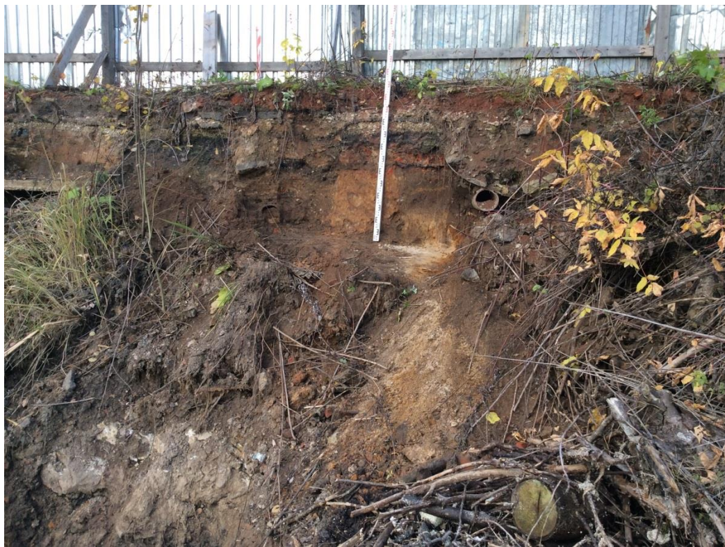
Рис. 20. Место проведения археологических разведок на земельном участке с кадастровым номером 40:26:000264:841 под объект «Многоквартирный жилой дом со встроенно-пристроенной автостоянкой по адресу: г. Калуга, ул. Пролетарская, д. 129». Зачистка 2. Вид с востока.
